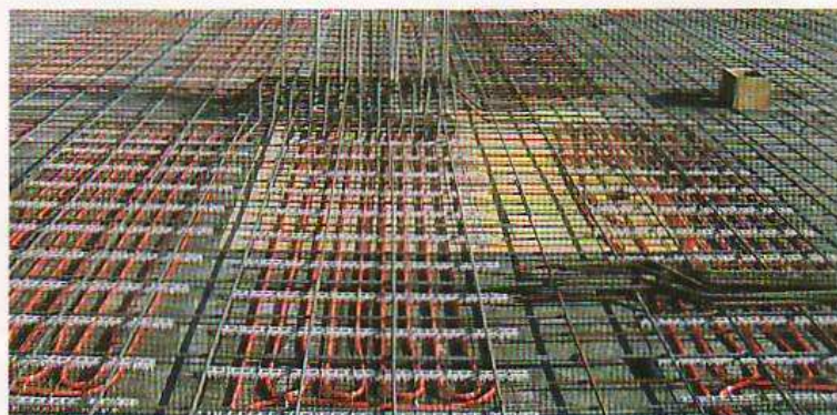
2. ábra. Födémbe épített rendszer (5-Let Ház, Dunakeszi)
